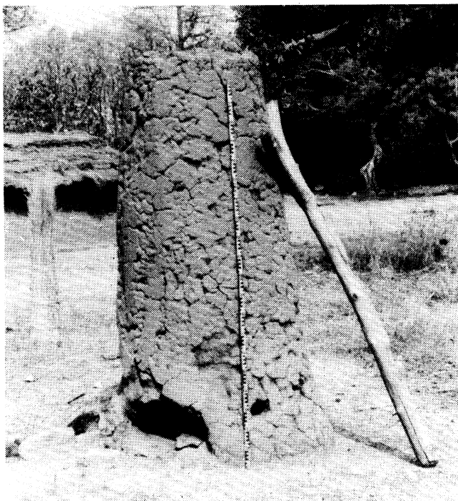
PHOTO 1 Bandjeli furnace (scale: 2-m rod)
